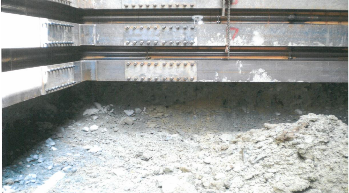
東大路幹線接続支線(その2)公共下水道工事 (掘削状況GL-6.8m付近)
